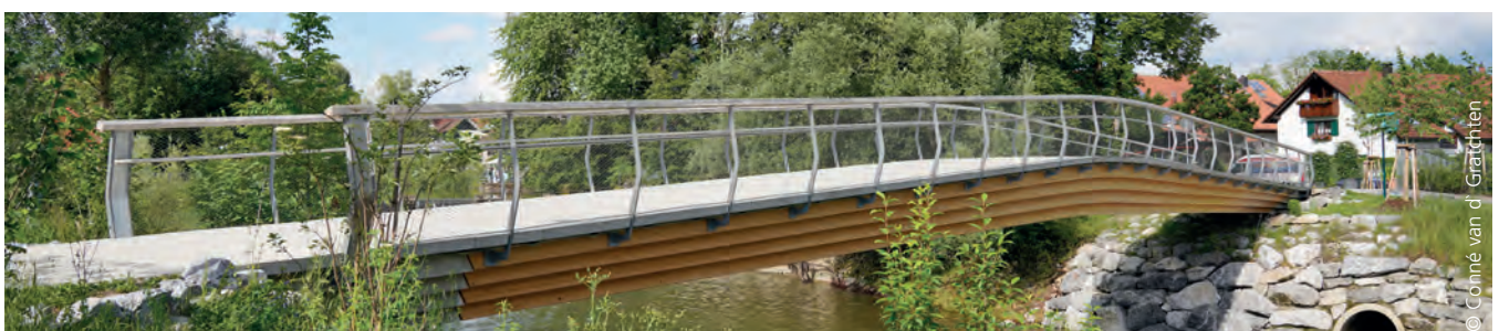
Die Blockträgerbrücke "Am Klösterle" mit 38 m hat einen Natursteinbelag und ist über Bolzen sehr "robust" an das Widerlager angeschlossen.
