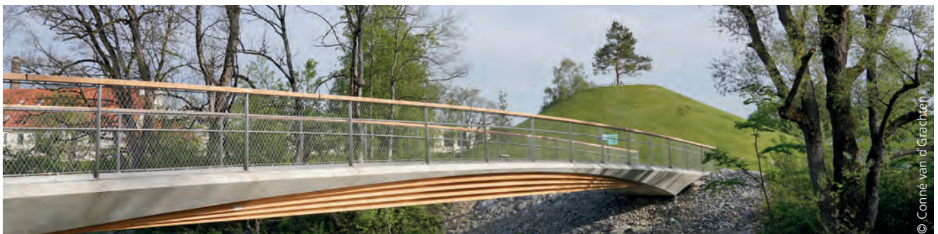
Zwei baugleiche Holz-Beton-Verbundbrücken führen über die Oberen Argen des Landesgartenschau Geländes in Wangen im Allgäu
